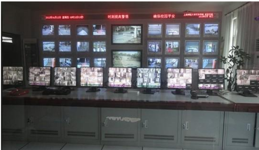
校园技防监控总控室
